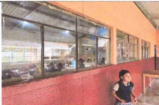
**FOTO 2: ES NECESARIO SUSTITUIR LAS VENTANAS EXISTENTES POR VENTANAS CORREDIZAS**
