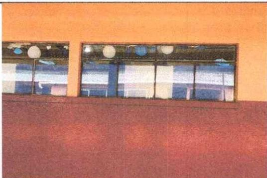
**FOTO 1: NO HAY VENTILACIÓN EN EL AULA ES MINIMA DEBIDO A QUE LAS VENTANAS NO SON CORREDIZAS**
